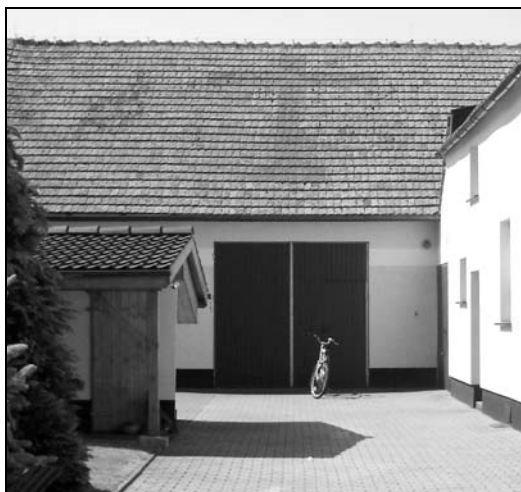
Fot. 8. Wielki symbol krzyża na dachu, powstały poprzez wykorzystanie kolorystyki dachówek.
