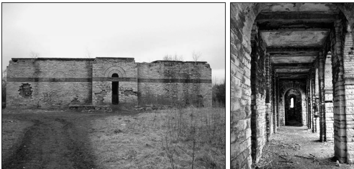
Fot. 14. Ruiny mauzoleum bojowników ruchu narodowo-socjalistycznego w Wałbrzychu (projekt Roberta Tischlera, 1936-1938).
